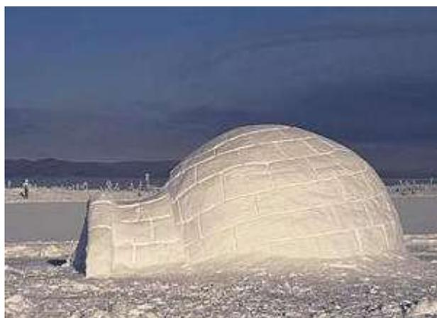
Les blocs de neige, découpés à l'aide d'un couteau, doivent être d'environ 1 mètre de long, 40 cm de haut et 20 cm de large. Il est conseillé de les poser en spirale pour faciliter la construction d'un dôme. L'entrée doit être positionnée le plus bas possible pour éviter que le vent glacial ne s'y engouffre.
